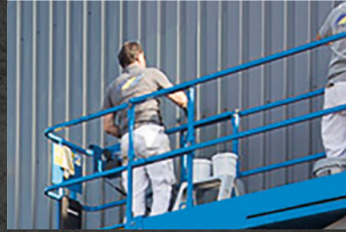
Opfrissen en renovatie van metalen gevelbekleding
