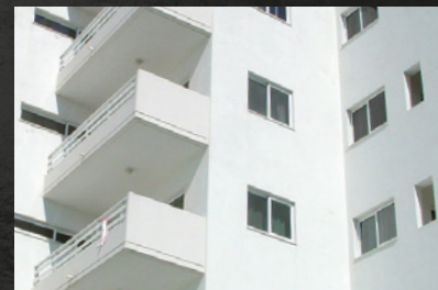
Waterdichting van buitenmuren
